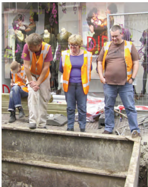
Afbeelding 160. De graafwerkzaamheden in de Langestraat trokken veel bekijks.
